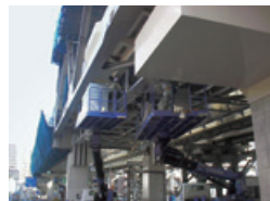
橋梁補修工事
